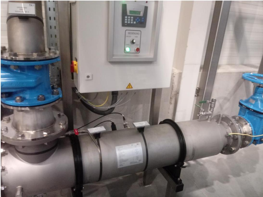
Abbildung 25: WVA Gemeindevasserversorgungsverband Felixdorf – Sollenau, Aufbereitungsstraße 3 (Wasser des Bohrbrunnen 2), Blick zum Gerät zur Desinfektion von Wasser mittels Ultraviolettstrahlung 5.
