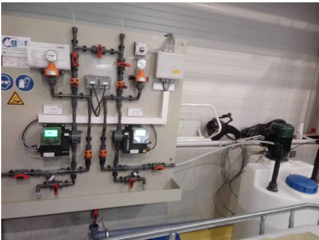
Abbildung 12: WVA Gemeindewasserversorgungsverband Felixdorf – Sollenau, Aluminiumhydroxidchloridsulfat (Flockungsmittel) - Station für Aufbereitungsstraße 1.
