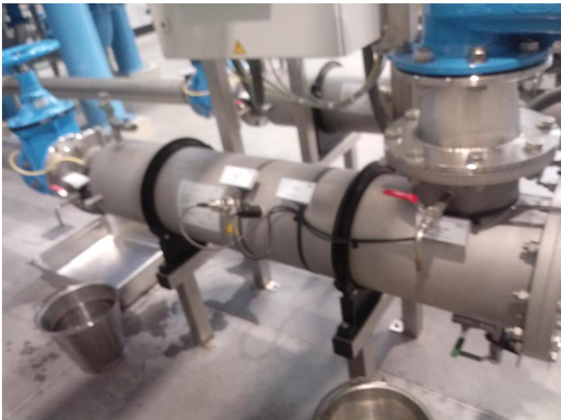
Abbildung 11: WVA Gemeindewasserversorgungsverband Felixdorf – Sollenau, Aufbereitungsstraße 1, Gerät zur Desinfektion von Wasser mittels Ultraviolettstrahlung 2, nach Mehrschichtfilter Linie 2.
